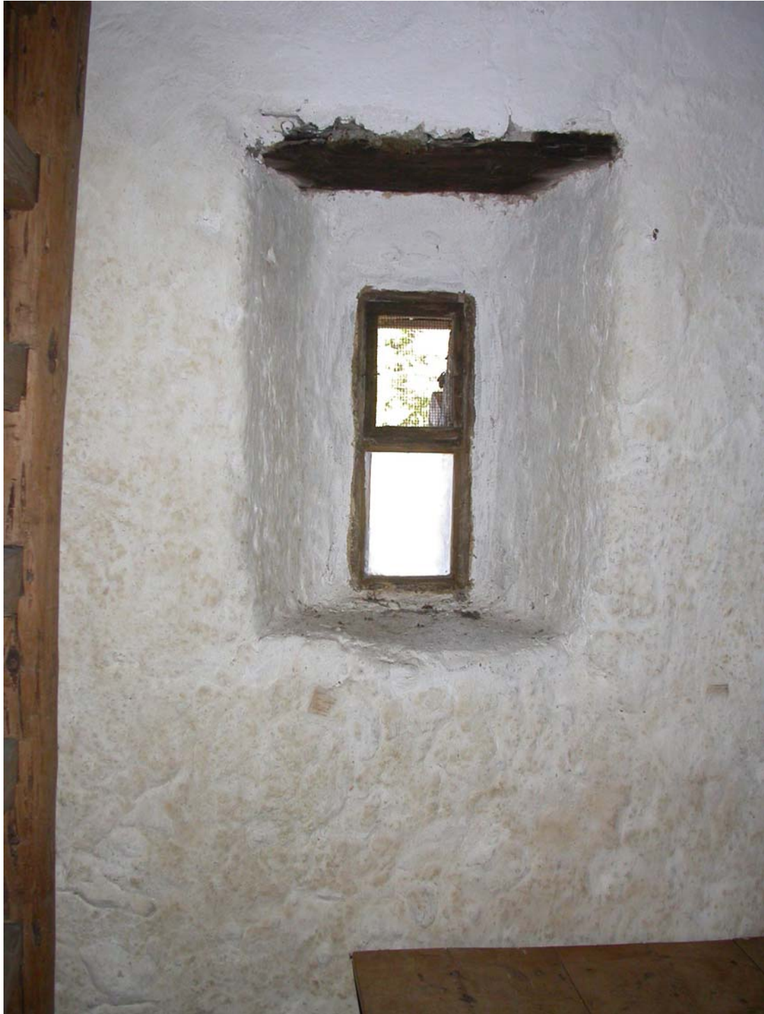
La « bornatz » de la cave à fromage, avec fenêtre en deux parties, un verre pour le bas, un treillis pour le haut.
